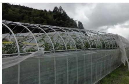
昨年の台風により、パイプが押され折れ曲がった様子 (防府市大道)
