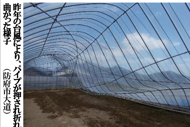
令和2年の台風により、パイプが折れ曲がった様子(山口市阿東)
