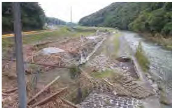
河川の氾濫により倒壊したハウス(令和5年7月2日撮影)
